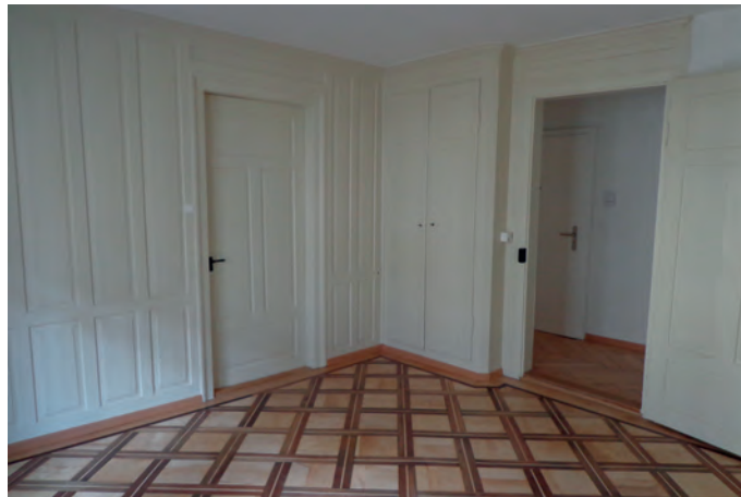
Typisches Wohnzimmer einer Wohnung mit aufgefrischem Parkett und Wandtäfer, originalen Zimmertüren und Wandschrank. Lediglich die früher wohl einmal vorhandene Stuckdecke war in diesem Raum bereits vor der Renovation nicht mehr erhalten.
