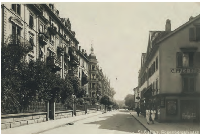
Die Rosenbergstrasse im frühen 20. Jahrhundert. Links im Bild die Häuserzeile Nr. 62-74, noch mit der ursprünglichen Einfriedung und dem Vorgarten, welche beide im Laufe der Zeit der Strassenverbreiterung zum Opfer fielen.
